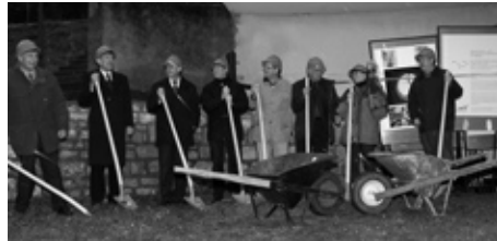
Spatenstich und Start zu umfangreichen Neubau- und Sanierungsarbeiten im Effingerhort, REHA-Haus.
